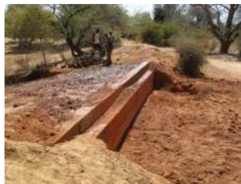
Début de réparation de la diguette
